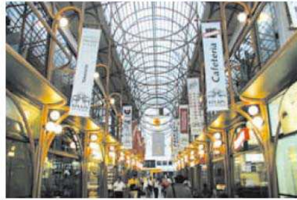
상가 활성화를 위해 보행자가 비를 맞지 않도록 값이싼 파이프를 이용하여 유리천장을 만들었다.
