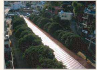
경남 통영 해저터널-지붕재
