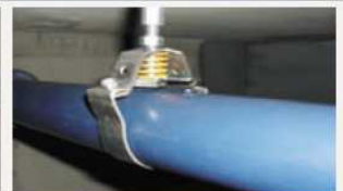
기계 설비, 통신 설비, 전기 설비, 트레이 내진설계용 "내진 체인 스프링가대"
