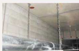
기계 설비, 통신 설비, 전기 설비, 트레이 내진설계용 "내진 체인 스프링가대"
