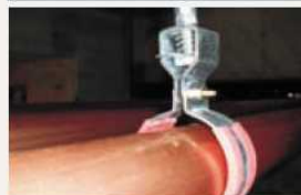
기계 설비, 통신 설비, 전기 설비, 트레이 내진설계용 "내진 체인 스프링가대"
