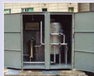
시청 세차시설 액체청정여과장치 시공
