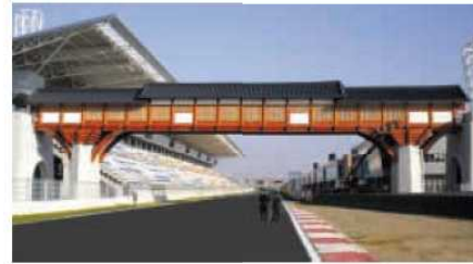
F1 자동차 경주장 구조용집성체 한식육교
