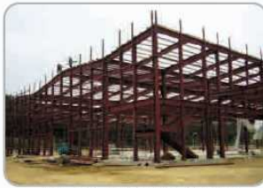
순창 소모 세차기 공장 설치 과정
