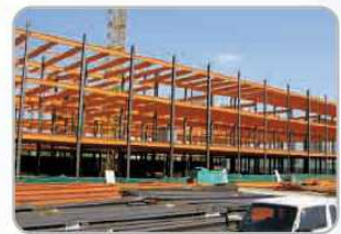
청단 아울렛 코리아 설치 과정
