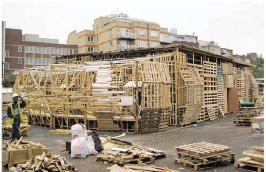
그림 2. 2010 런던 건축 페스티벌을 위하여 만들어진 JellyFish Theatre. 폐기물을 이용하였으며, 자원 봉사자들에 의하여 세워졌다. 화재 및 안전 법규를 준수하여 만들어 졌다. AJ (Architect's Journal) Small Projects Awards상을 수상하였다.
