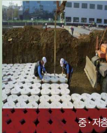
빠른시공, 무소음, 무진동, 비배토공법 ROTARY PILE
