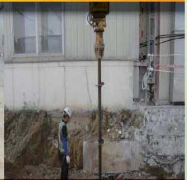
빠른시공, 무소음, 무진동, 비배토공법 ROTARY PILE
