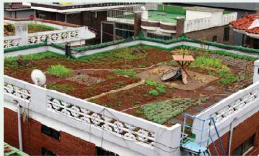
우리나라의 주택은 평지붕이 많다. 여름에는 뜨겁고, 겨울에는 춥다. 부족한 대지면적에 옥상을 녹지공간으로 조성하여 지붕의 열성효과를 줄이고, 보온효과를 얻으며 생태적인 생활공간을 확보하는 것은 개인의 삶의 질을 향상시켜 준다. 그리고 도시를 새로운 환경으로 창조시켜 간다.
