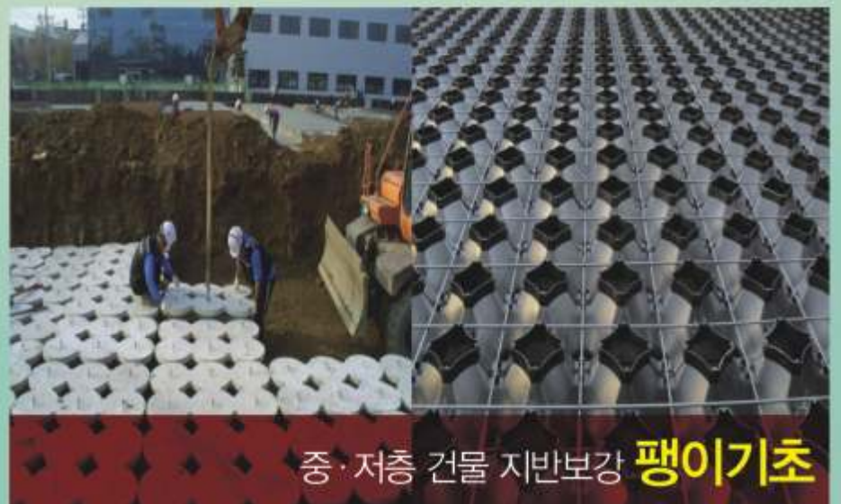
빠른시공, 무소음, 무진동, 비배토공법 ROTARY PILE
