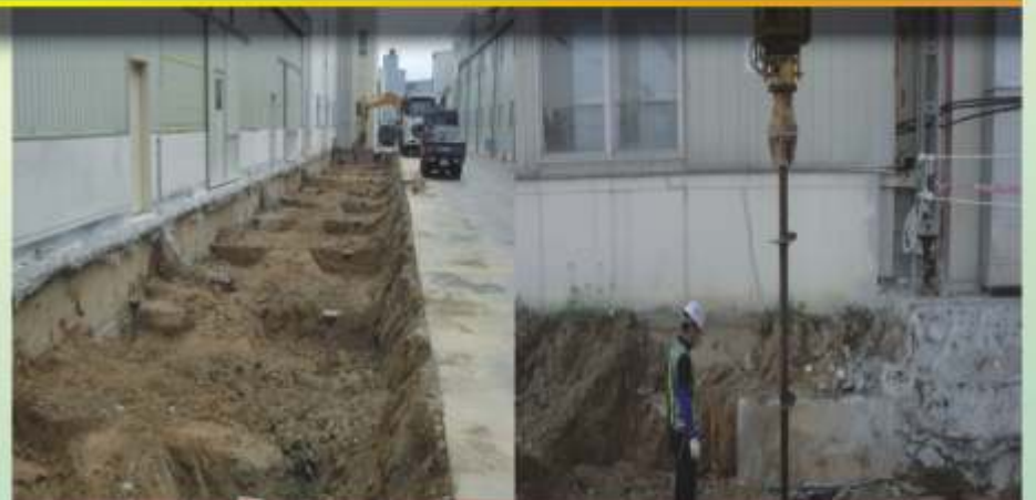
빠른시공, 무소음, 무진동, 비배토공법 ROTARY PILE
