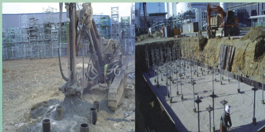
신축, 증축, 리노베이션, 기초보강 MICRO PILE
