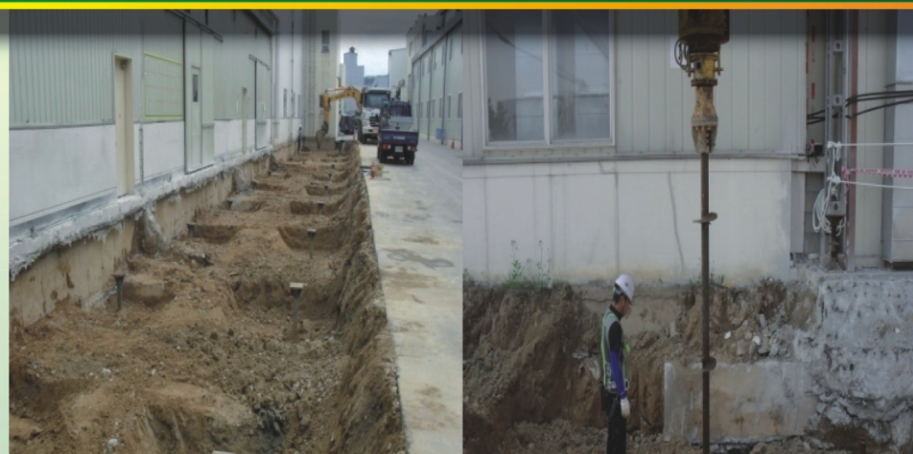
빠른시공, 무소음, 무진동, 비배토공법 ROTARY PILE
