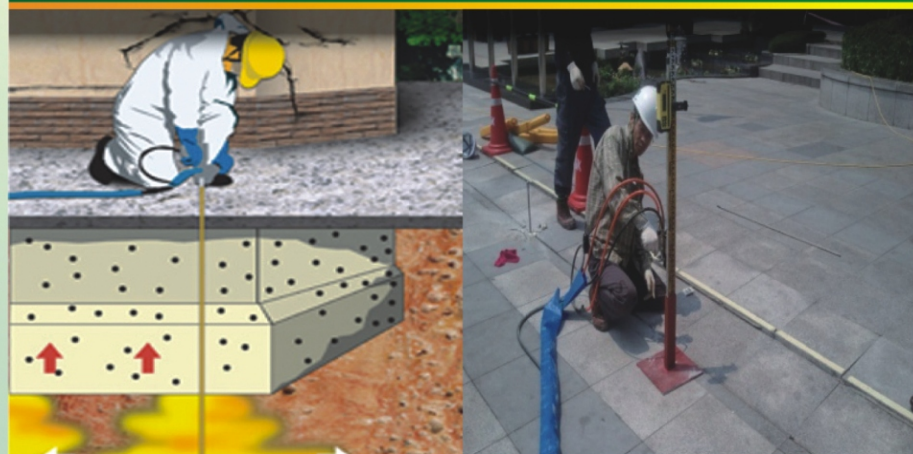
고밀도 지반보강 GEOCON 공법
