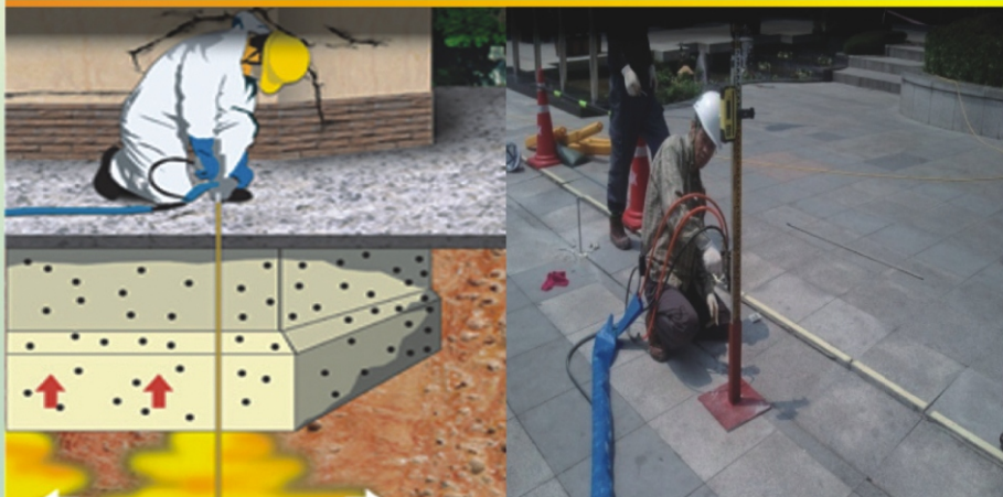
고밀도 지반보강 GEOCON 공법
