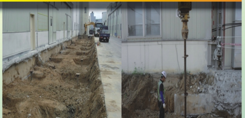
빠른시공, 무소음, 무진동, 비배토공법 ROTARY PILE
