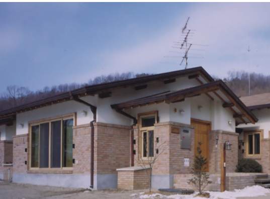
1) '살림의 주택', (임산소재, 필자설계): 전통성을 현대건축에 구현한 작업의 예(처마, 외벽처리, 지붕의 형태 및 중첩, 공간적분할)
