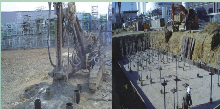
신축, 증축, 리노베이션, 기초보강 MICRO PILE
