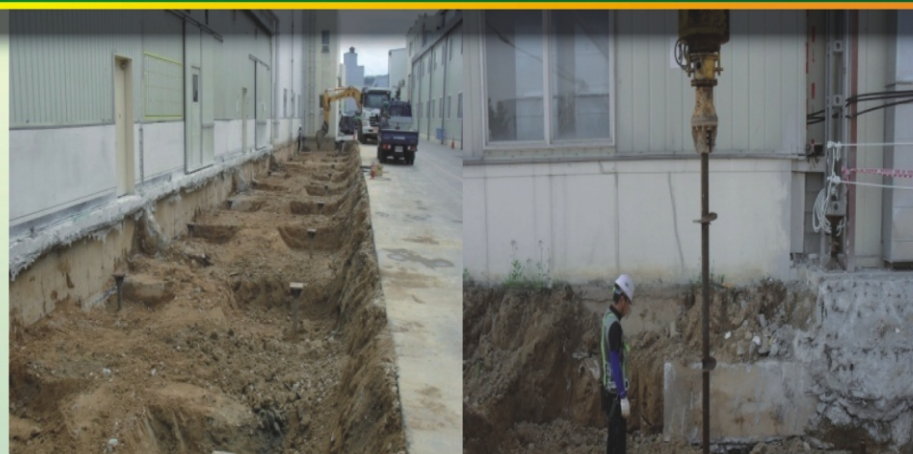
빠른시공, 무소음, 무진동, 비배토공법 ROTARY PILE
