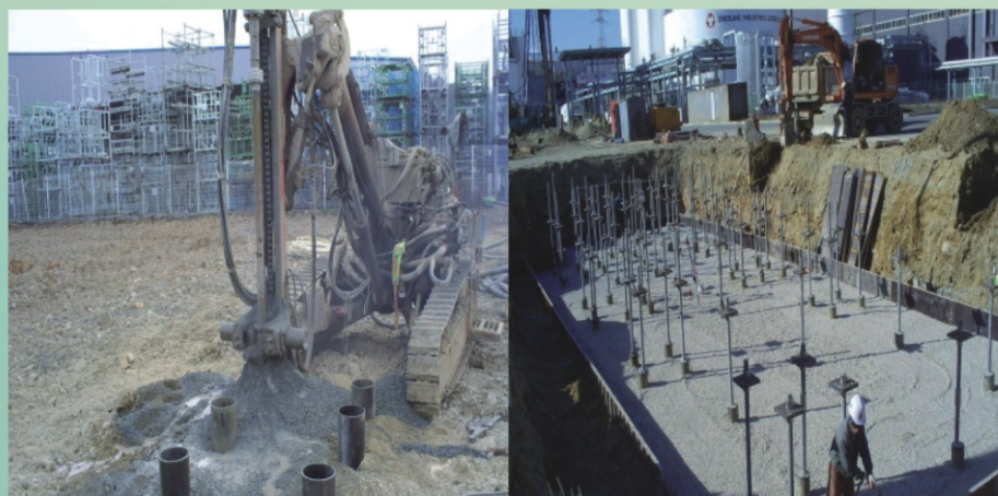
신축, 증축, 리노베이션, 기초보강 MICRO PILE
