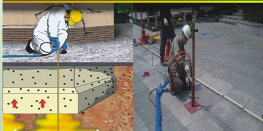
고밀도 지반보강 GEOCON 공법
