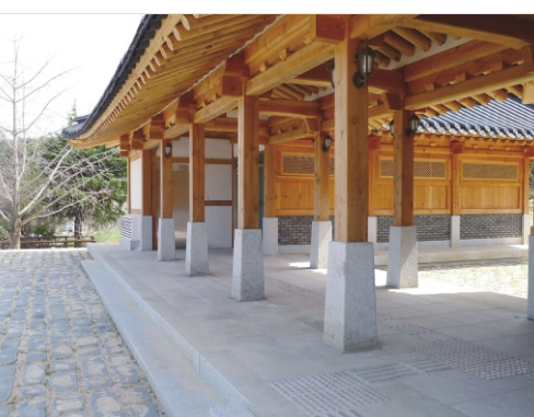
▲ 장성 홍길동 테마파크 화장실
