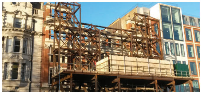
▲ 사진4, 기존의 고전 외벽을 살린 신축건축
