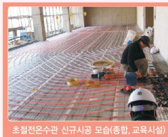
초절전온수관 신규시공 모습(종합, 교육시설)
