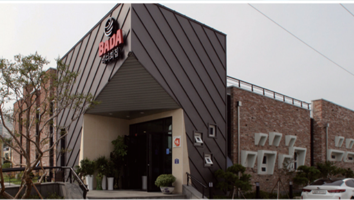
대지위치 : 전라북도 군산시 나운동 549-9번지 / 대지면적 : 1,289.00㎡ / 건축면적 : 408.84㎡ / 연면적 : 398.81㎡ / 구조 : 철근콘크리트 / 용도 : 근린생활시설 층수 : 지상 1층 / 외부재료 : 고벽돌치장쌓기, 접합강판거울접기
