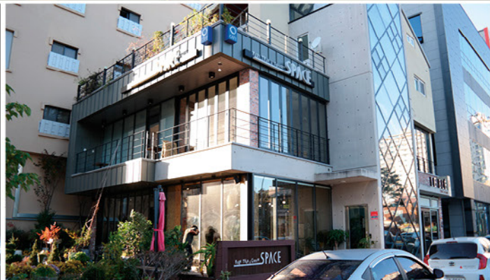
대지위치 : 전라남도 순천시 왕지동 856-7 / 대지면적 : 421.20㎡ / 건축면적 : 187.38㎡ / 연면적 : 462.22㎡ / 건폐율 : 44.48% / 용적률 : 109.73% 구조 : 철근콘크리트조 / 용도 : 근린생활시설, 주택 / 외부 마감재 : 노출콘크리트, THK0.6 프린트강판, THK24 로이복층유리, 고벽돌 치장쌓기
