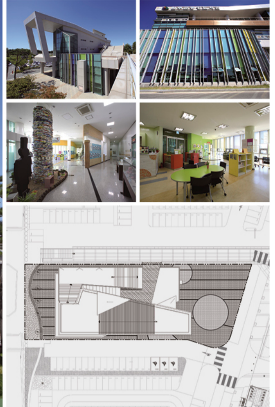
대지위치 : 전라북도 완주군 용진면 운곡리 / 대지면적 : 54,118㎡ / 건축면적 : 1,095.79㎡ / 연면적 : 2,410.29㎡ / 규모 : 지하 1층, 지상 3층 주용도 : 공공청사(도서관) / 구조 : 철골조, 철근콘크리트조 / 주요 마감 : A.L.쉬트, 압출성형시멘트판넬, 고밀도 압축패널, 징크판넬
