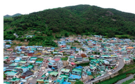
▲ 새마을사업이 추진 중인 여수 광림지구 모습
