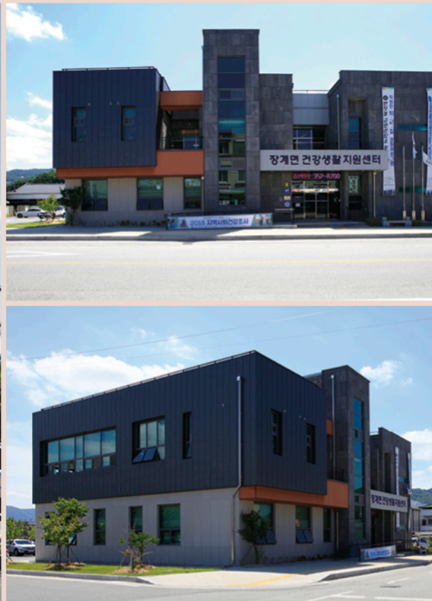
대지위치 : 전라북도 완주군 장계면 한들로 124 / 대지면적 : 1,738.00㎡ / 건축면적 : 449.58㎡ / 연면적 : 808.77㎡ / 용도 : 제1종 근린생활시설 규모 : 지하 1층, 지상 2층 / 구조 : 철근콘크리트구조 / 주요마감 : 화산석, 압출성형시멘트패널, 고내식발색강판, 친환경합성목재
