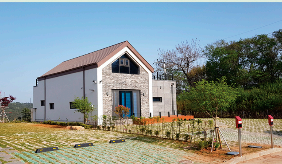
대지위치 : 전라남도 순천시 해룡면 호두리 1234 / 대지면적 : 548.50㎡ / 건축면적 : 124.02㎡ / 연면적 : 103.77㎡ 건폐율 : 22.61% / 용적률 : 18.92% / 주용도 : 단독주택 / 규모 : 지상 1층 / 구조 : 철근콘크리트구조
