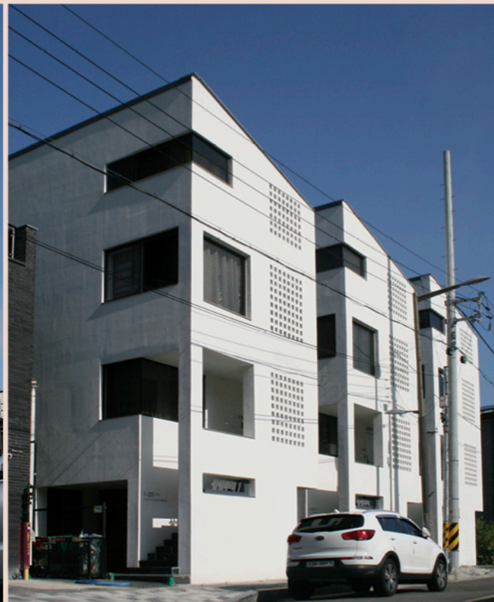
대지위치 : 전라북도 전주시 덕진구 송천동 250, 250-2, 250-3번지 / 건축면적 : 80.00㎡, 80.00㎡, 80.60㎡ 연면적 : 171.28㎡, 171.28㎡, 172.48㎡ / 용도 : 다가구주택 / 규모 : 지상 3층 / 구조 : 철근콘크리트 라멘조 / 주요 마감 : 스테코플렉스
