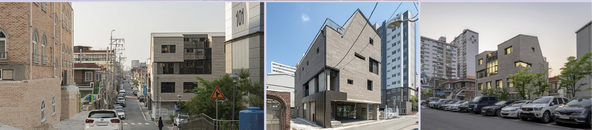
대지위치 : 광주광역시 남구 진월동 333-14 / 대지면적 : 183㎡ / 건축면적 : 108.8㎡ / 연면적 : 378.14㎡ / 건폐율 : 59.45% / 용적률 : 164.50% 규모 : 지하 1층, 지상 4층 / 주용도 : 다가구주택 및 근린생활시설 / 구조 : 철근콘크리트구조 / 주요 마감 : 지장벽돌쌓기, 리얼징크마감
