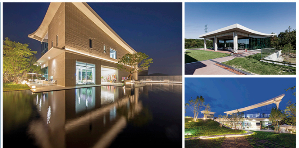
대지위치 : 전라북도 전주시 덕진구 원동로 16 / 대지면적 : 4,878㎡ / 건축면적 : 859.968㎡ / 연면적 : 1,838.094㎡ 규모 : 지하 1층, 지상 2층 / 주용도 : 제1·2종 근린생활시설 / 구조 : 철근콘크리트 / 주요 마감 : 노출콘크리트, 단열커튼월 + 24MM 로이복층유리
