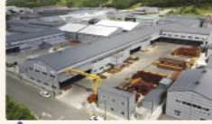
태신중공업 담양 2공장 (대지면적 : 7,189㎡(2,175평))
