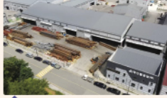
태신중공업 담양 1공장 (대지면적 : 6,930㎡(2,100평))
