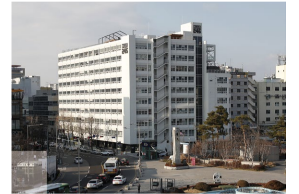
리모델링부문 최우수상 '전일빌딩 245'
