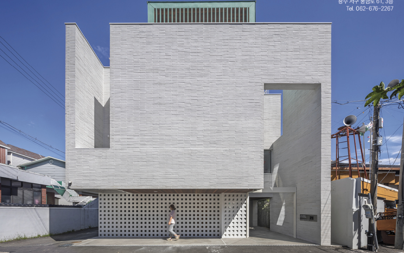
대지위치 : 경상북도 영천시 망정동 / 대지면적 : 147.00㎡ / 건축면적 : 86.30㎡ / 연면적 : 198.16㎡ / 건폐율 : 58.71% 용적률 : 134.80% / 규모 : 지상 4층 / 구조 : 철근콘크리트구조 / 주요 마감 : 롱브리타일, 부식동판, 알루미늄루버 등 / 건축사진 : 윤준환
