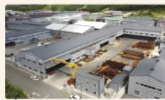
태신중공업 담양 2공장 (대지면적 : 7,189㎡(2,175평))
