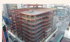
신용동 업무시설 및 주차빌딩 신축
