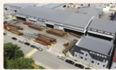
태신중공업 담양 1공장 (대지면적 : 6,930㎡(2,100평))
