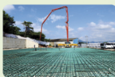
함평 경서중공업 공장
