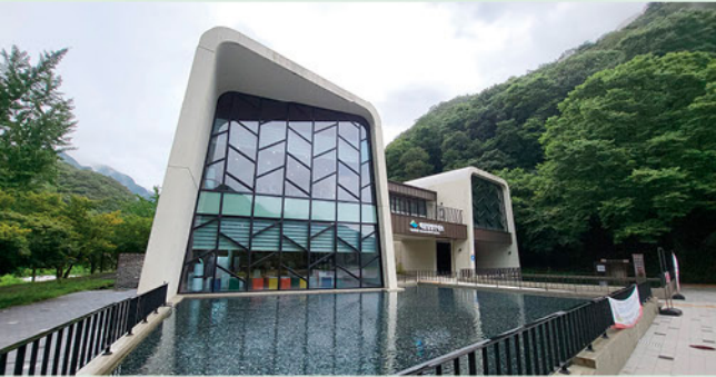
대지위치 : 전라남도 장성군 북하면 약수리 146번지 / 대지면적 : 3,000㎡ / 건축면적 : 449.52㎡ / 연면적 : 813.36㎡ / 규모 : 지상 2층 주용도 : 제1종 근린생활시설(공공업무시설) / 구조 : 철근콘크리트구조 / 주요 마감 : 노출콘크리트, 커튼월, 파주식
