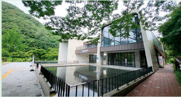
대지위치 : 전라남도 장성군 북하면 약수리 146번지 / 대지면적 : 3,000㎡ / 건축면적 : 449.52㎡ / 연면적 : 813.36㎡ / 규모 : 지상 2층 주용도 : 제1종 근린생활시설(공공업무시설) / 구조 : 철근콘크리트구조 / 주요 마감 : 노출콘크리트, 커튼월, 파주식
