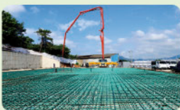
함평 경서중공업 공장
