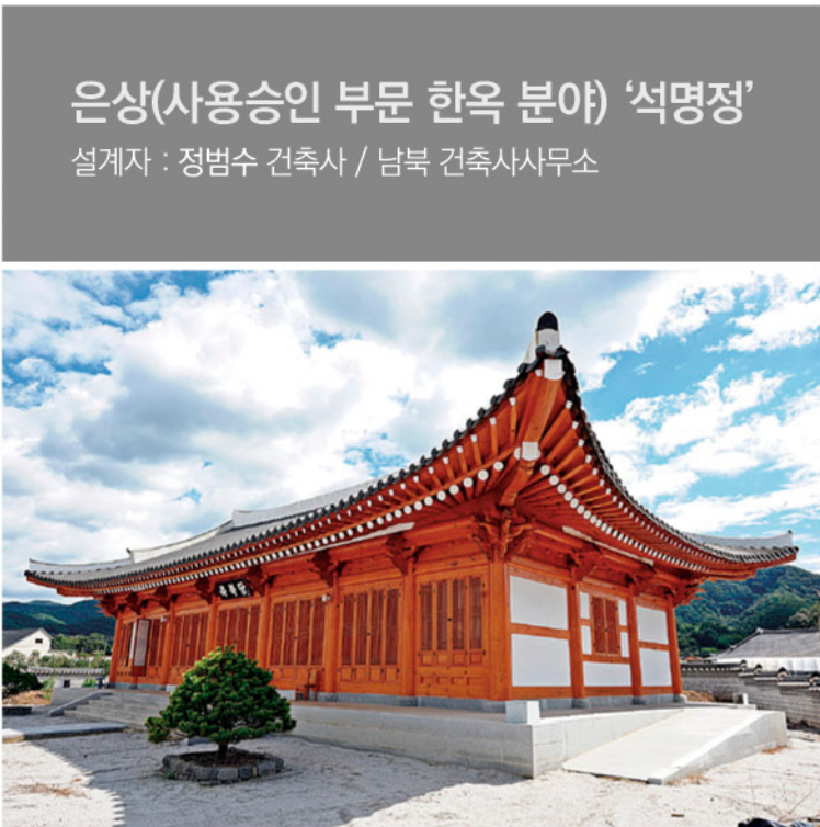
대지위치 : 전북 정읍시 산외면 평사리 413-1, 416-2 / 대지면적 : 2,961㎡ / 건축면적 : 309.57㎡ 연면적 : 309.57㎡ / 규모 : 지상 1층 3개동 / 주용도 : 단독주택 / 구조 : 전통 목구조 / 주요마감 : 회백가람, 팔작지붕
