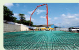
함평 경서중공업 공장
