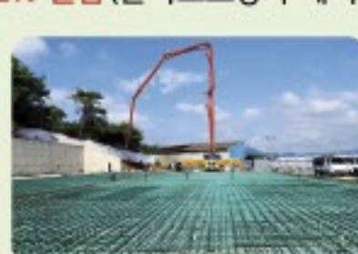
함평 경서중공업 공장
