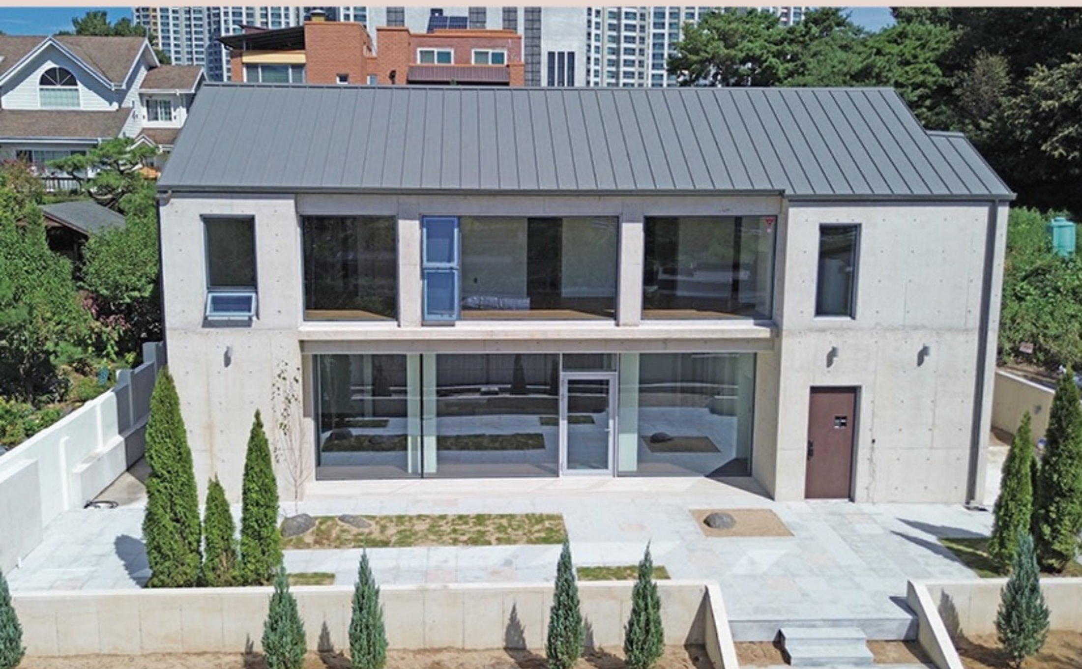
대지위치 : 전북특별자치도 전주시 완산구 삼천동2가 207-9 / 대지면적 : 595㎡ / 건축면적 : 116.5㎡ / 연면적 : 199.2㎡ 규모 : 지상 2층 / 주용도 : 단독주택 / 구조 : 철근콘크리트구조 / 주요 마감 : 체치장(노출)콘크리트, 롱브릭타일 벽돌
