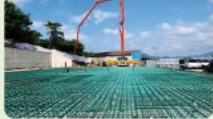
함평 경서중공업 공장
