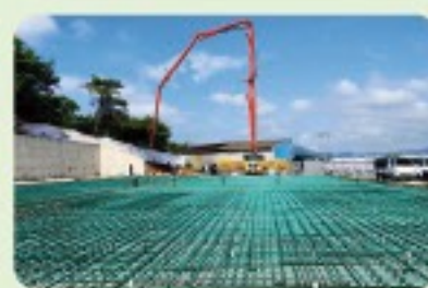
함평 경서중공업 공장
