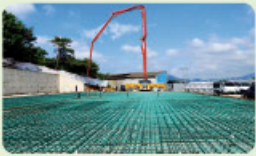
함평 경서중공업 공장
