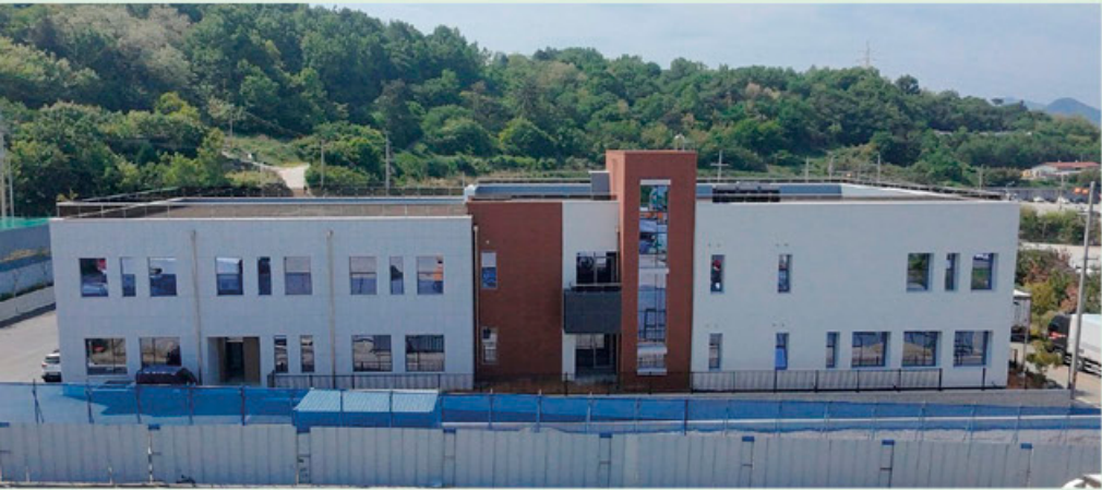
대지위치 : 전라남도 여수시 주상동 A4-5 / 대지면적 : 4,016.90㎡ / 건축면적 : 1028.72㎡ / 연면적 : 1988.39㎡ / 규모 : 지상 2층 주용도 : 교육연구시설(연구소) / 구조 : 철근콘크리트구조 / 주요 마감 : 화강석, 세라믹패널, 테라코타
