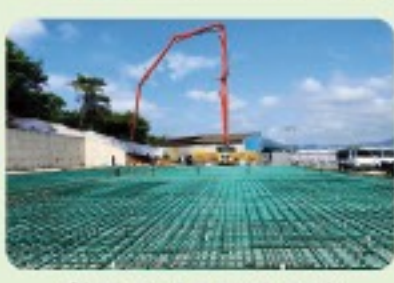
함평 경서중공업 공장
