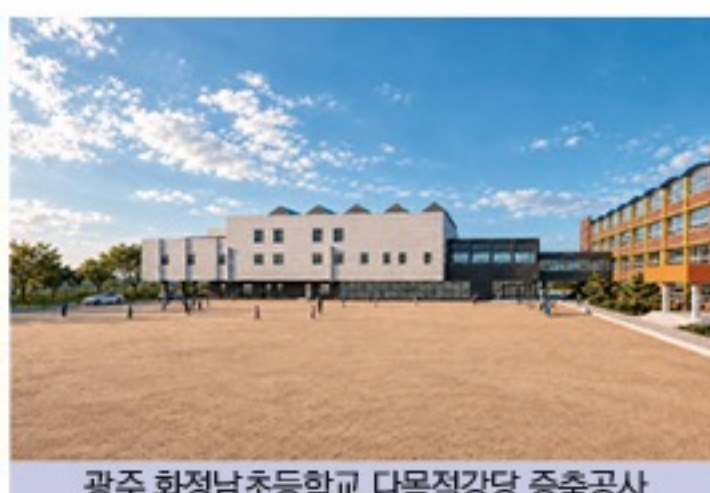
광주 화정남초등학교 다목적강당 증축공사
